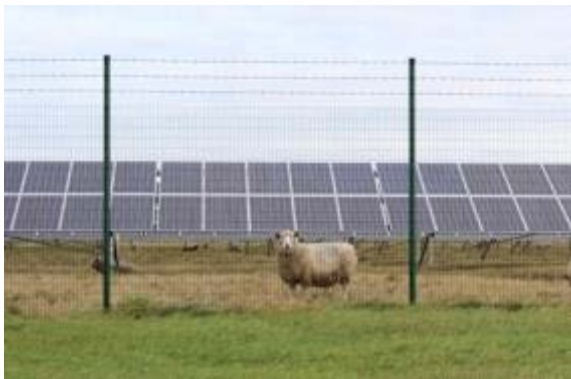
Abbildung 19: Ein stabiler Stabgitterzaun mit Bodenschluss ist für die Schafbeweidung optimal (Foto: M. Gertenbach, LWK Niedersachsen. Solarpark in Ovelgönne, Landkreis Wesermarsch).
