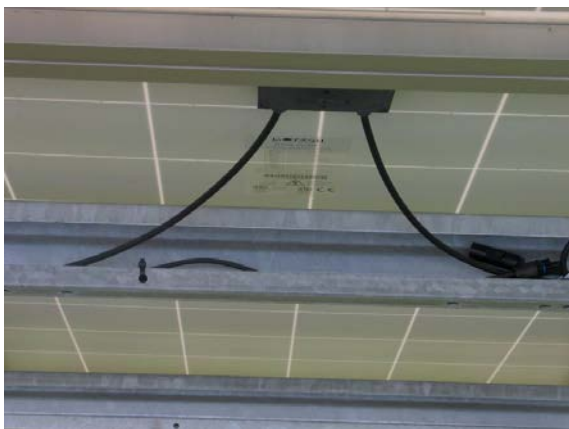
Abbildung 17: Verlegung der Kabel im Ständerprofil (Foto: M. Jurkschat).
