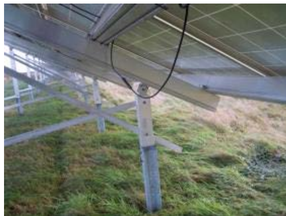
Abbildung 14: Die Kabel wurden leider nicht in die vorhandenen Kabelschächte gelegt und stellen so eine Gefahr dar (Foto: M. Gertenbach, LWK Niedersachsen).
