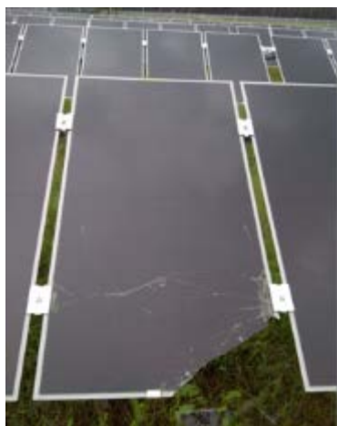
Abbildung 9a und b: Schädigung von niedrig aufgehängten Dünnschichtmodulen durch Schafe (Hunde von Spaziergängern verschreckten die Schafe – Fotos: DiSUN Management & Service GmbH).
