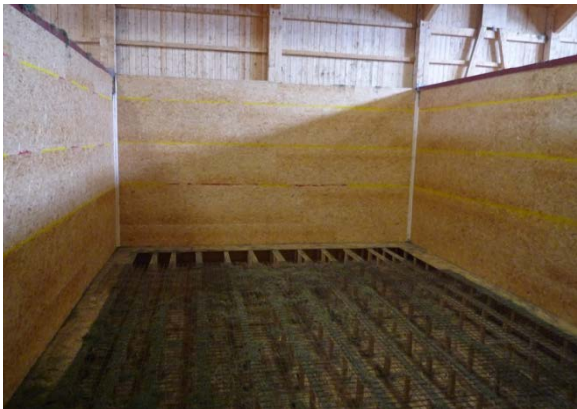
Abb. 1: Leere Heubelüftungsbox mit Bodenkonstruktion
