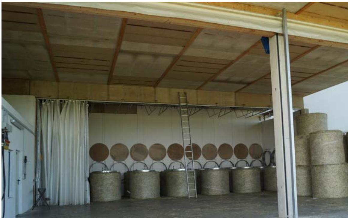
Abb. 2: Rundballenbelüftung mit Vorhang für Umluftbetrieb
