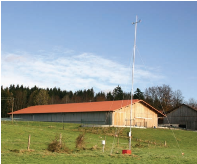
Abb. 3: Wetterstation vor dem Betrieb A
