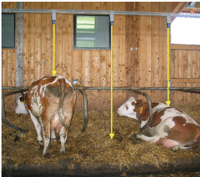
Abb. 8: Erkennung der Liegeboxenbelegung über Ultraschallsensoren
