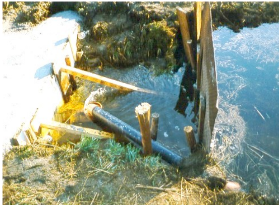
Fertigstellung des Ablaufes mit einbetoniertem Kunststoffrohr
